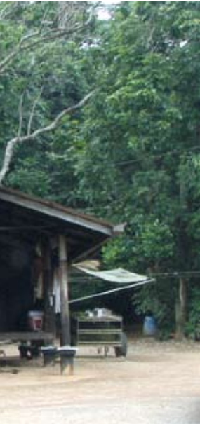
โรงน้ำร้อน เป็นที่ฉันทน้ำร้อน น้ำปานะ ของพระเถรในช่วงปลาย สร้างเสร็จในปี พ.ศ. ๒๕๐๗ กว้าง ๘ เมตร ยาว ๘ เมตร เสา ๑๖ ต้น ลักษณะทั่วไป เสาไม้ตั้งบน ตอม่อคอนกรีต พื้นเป็นดิน มุมหนึ่ง ยกพื้นไม้ ใช้ฝาไม้กันเป็นห้อง เก็บของ หลังคาทรงหน้าจั่ว มุงสังกะสีพร้อมเตาไฟ ก่อด้วย คอนกรีตมีปล่องควัน ๒ เตา สร้างเมื่อ พ.ศ.๒๕๒๒
